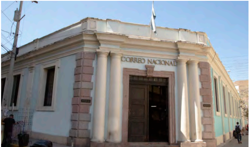
Fachada del edificio de la Empresa de Correos de Honduras.
